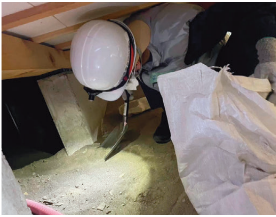
輪島市 床下清掃
